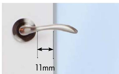
Espacio **mínimo de 11mm** entre el pomo y el principio de la moldura interior (mientras sea una superficie plana).
